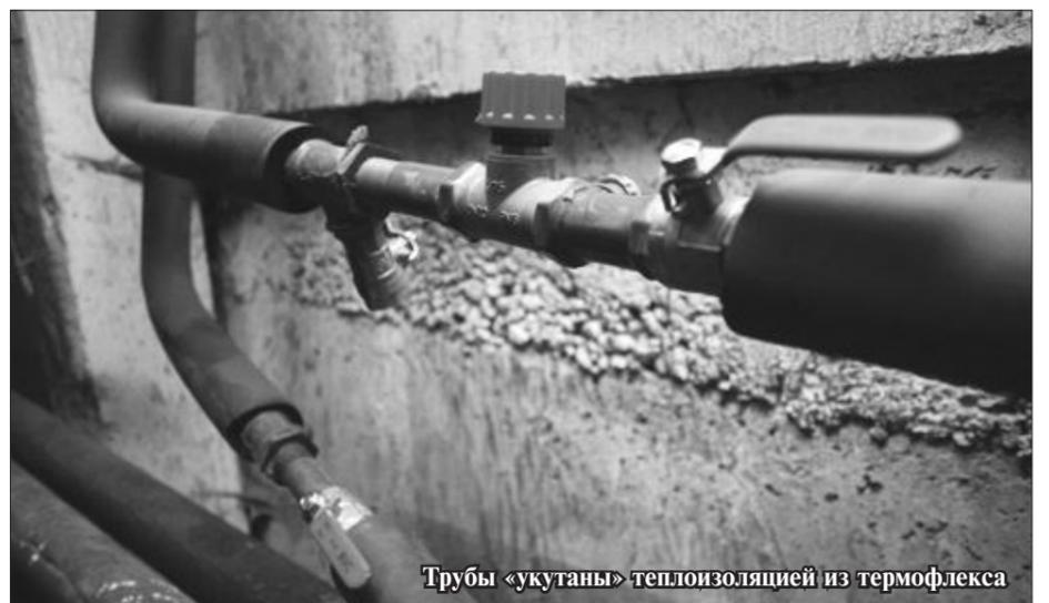
Трубы «укутаны» теплоизоляцией из термофлекса
