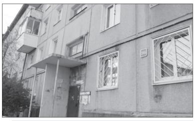
В доме № 246 по улице Ярославского отремонтировали межпанельные швы. «Мы проводим анализ заявок жителей в единую диспетчерскую службу. Делаем анализ актов температурного режима, термограмм, полученных в результате тепловизионной съемки. На ремонт межпанельных швов в этом доме согласились сразу – северная сторона, много жалоб от собственников», – говорит инженер.
