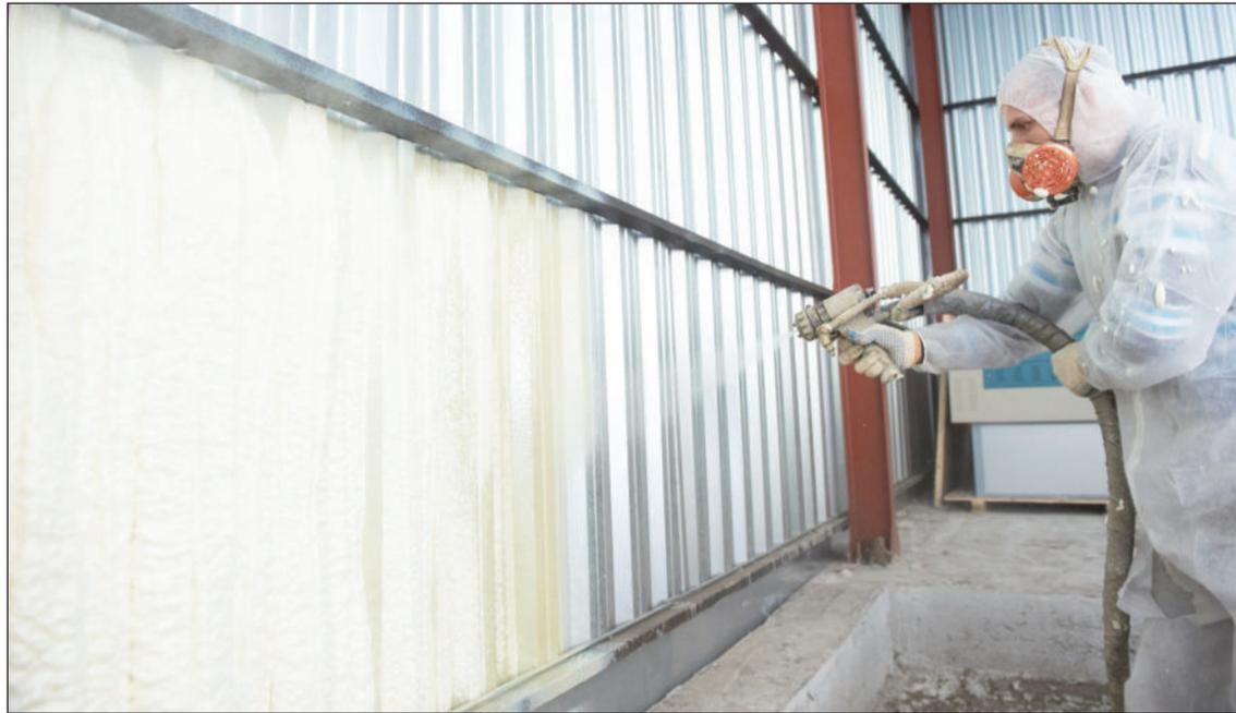
лиуретана на перекрытие проблема мгновенно решается: две воздушные среды, разделяемые ППУ, больше не станут соприкасаться друг с другом благодаря его низкой тепло- и паропроводности.
