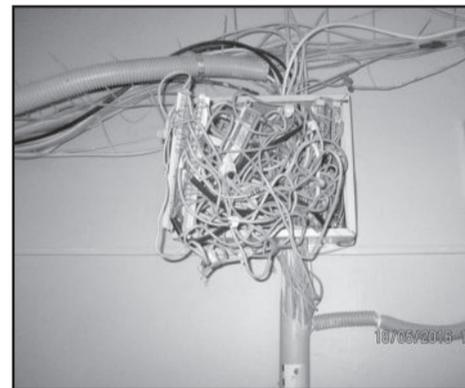
**Сломанный шифер на крышах, срезанные чердачные замки, гирлянды проводов в подъездах – иркутяне по праву возмущаются тем, как ведут себя операторы связи при установке оборудования для доступа в Интернет в жилых домах. Однако решить эту проблему могут только они сами.**
